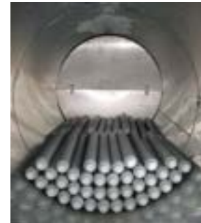
Accumulo latente a PCM (PCM S46 TubeICE) da 1000 l
