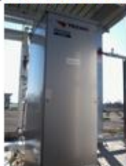
GRUPPO FRIGO AD ASSORBIMENTO ACQUA-BROMURO DI LITIO
