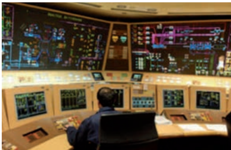
Sala di controllo di un reattore ad acqua pressurizzata di terza generazione avanzata
