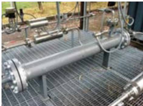
Cartridge di contenimento del modulo a membrane
