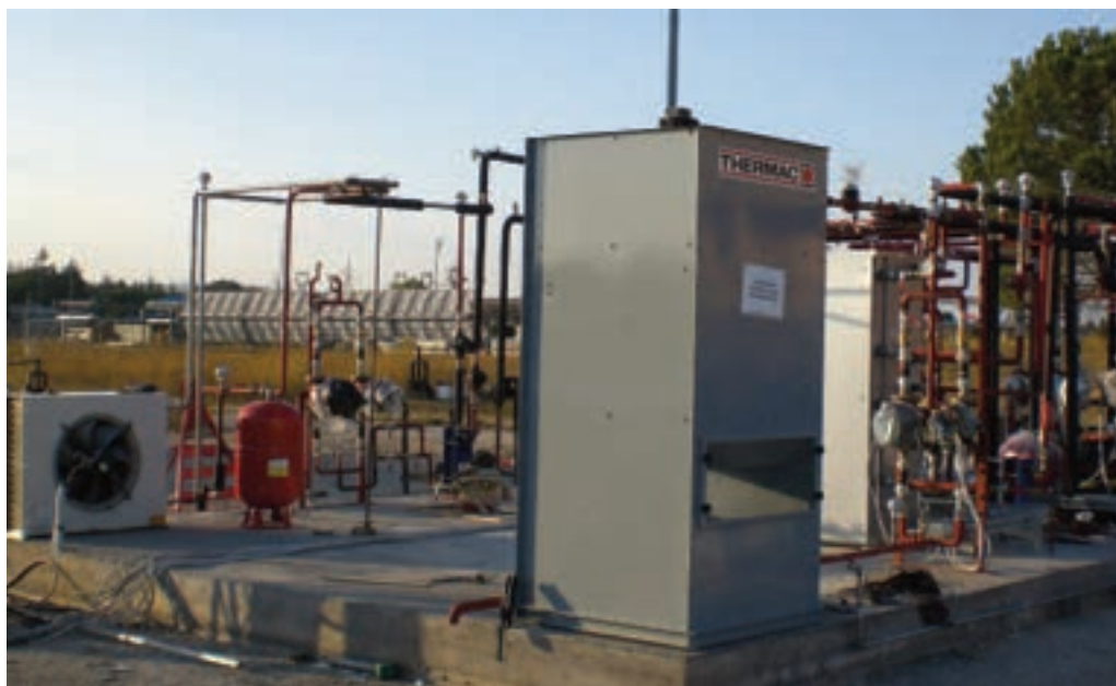
Impianto di solar heating and cooling innovativo a servizio dell'edificio F92 del CR ENEA Casaccia
